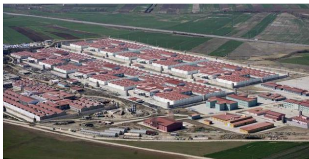
Vue d'ensemble de la citadelle carcérale de Silivri
