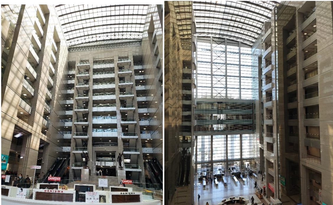
Vistas exterior e interior del Tribunal de Caqlayan en Estambul
